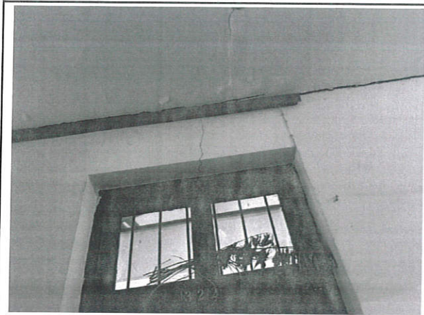
照片 7：三层 3-4/C 轴墙体竖向开裂情况
