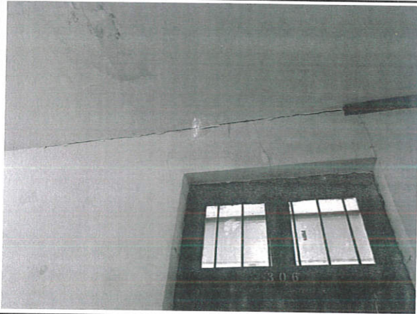
照片 4：三层 12-13/C 轴墙体竖向开裂情况
